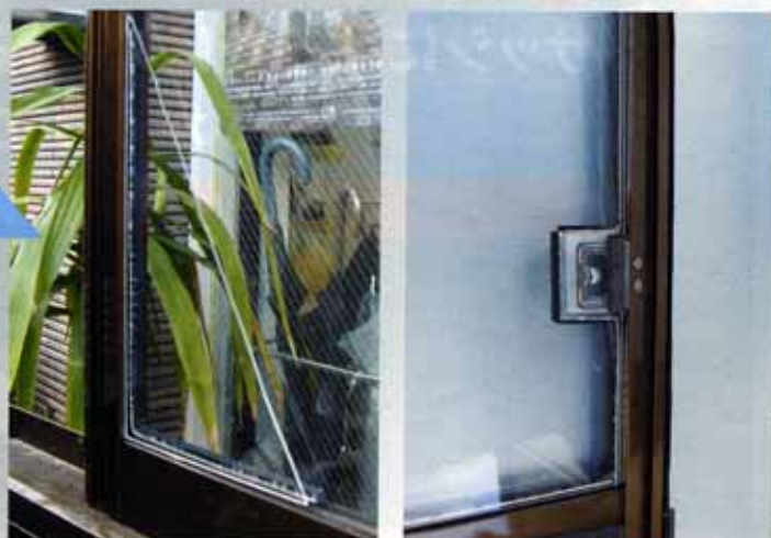
▲張付状態を見るためガラスをカットしてある
